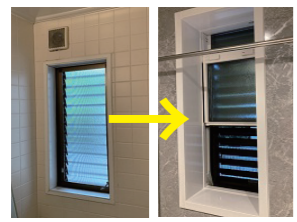
断熱性の低いルーバー窓からペアガラス入りの上げ下げ窓へ
